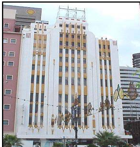
FIGUUR B: Die Kolosseum Gebou, WH Grant (Kaapstad), 1936–1938.
